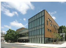
上戸田地域交流センター・ 戸田市立図書館上戸田分館
