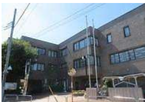
足立区舎人地域学習センター・ 図書館
