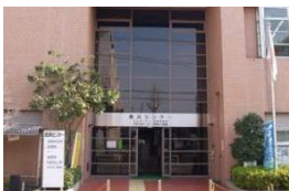
足立区鹿浜地域学習センター・ 図書館
